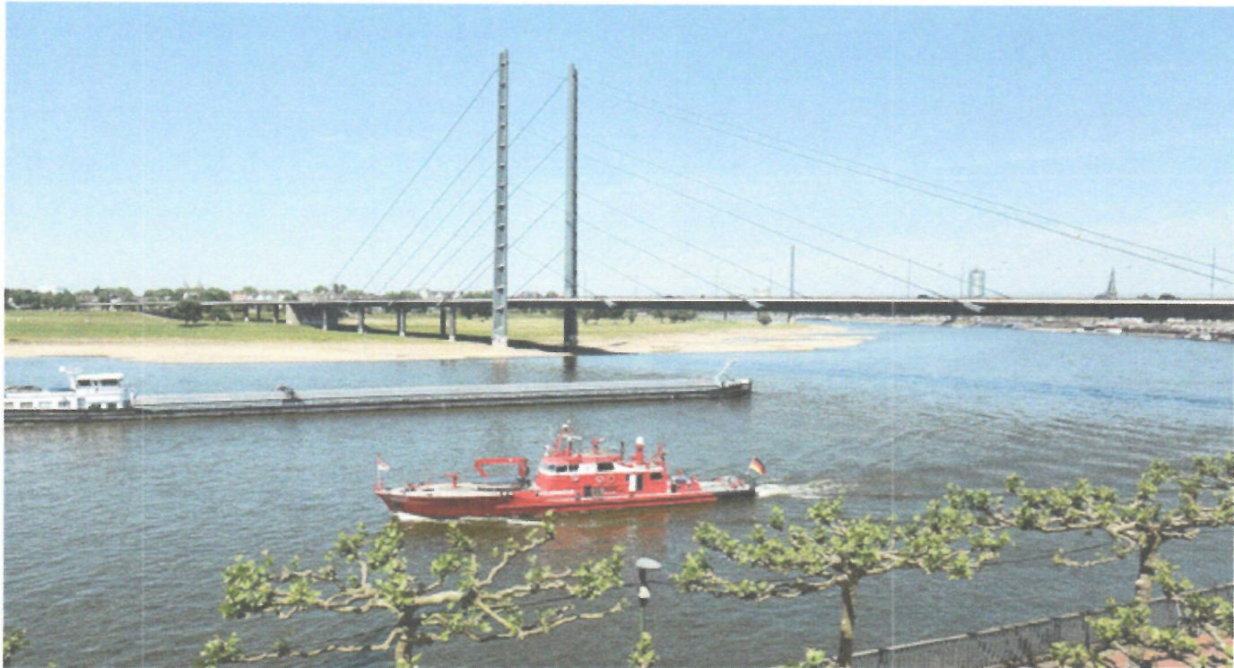
Der Blick vom rechten zum linken Rheinufer an der Düsseldorfer Rheinkniebrücke, die bald unter Denkmalschutz stehen könnte. FOTO: DPA VON NICOLE LANGE
